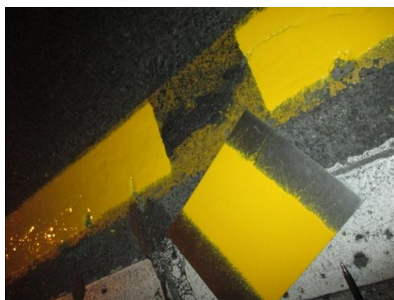
شکل ب-۱ اجرای خط کشی توسط خودرو خط کش روی صفحه نظارتی
